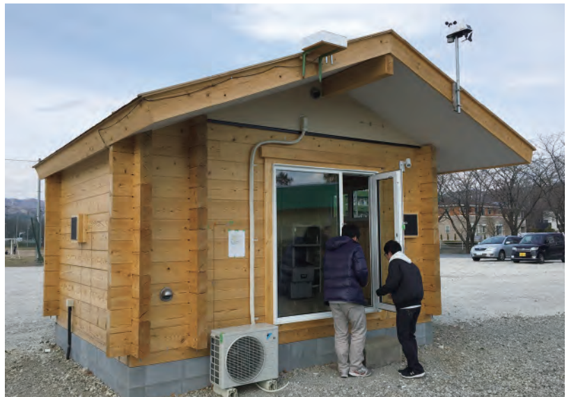
▲写真1 足利工業大学キャンパス内に建てたログハウスの実験棟。窓のサッシには、断熱性能の高い三層複層ガラス入りの樹脂サッシを採用した。
