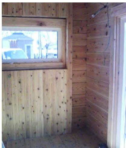
▲タテログ撤去作業中の様子。画面右側は既に撤去した状態。腰窓廻りにタテログが残っている。
